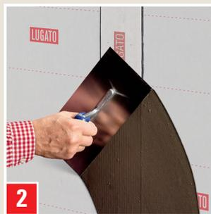
Ragréage des jointures de la bande d'étanchéité ABDICHTUNGSSBAHN pour préparer la pose de revêtements design ou vinyle.
