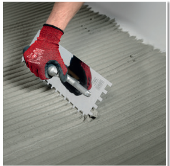
Gleichmäßiger Auftrag von Fliesenkleber.
