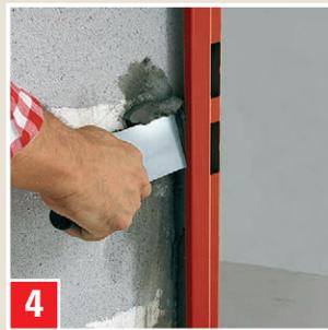
**Montage von feuerhemmenden Türen:** 5 MINUTEN MÖRTEL mit Kelle einbringen, verdichten und abglätten.
