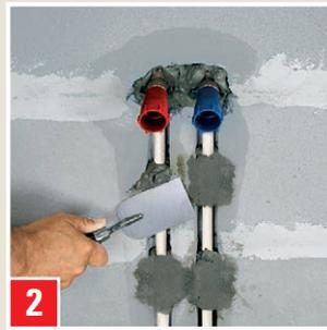
**Befestigung von Wasserleitungsrohren:** Montageteile in Position bringen. 5 MINUTEN MÖRTEL mit Kelle einbringen, verdichten und abglätten.
