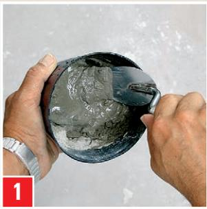
**Anmischen:** sauberes Wasser vorlegen und 5 MINUTEN MÖRTEL einrühren (ca. 190 ml Wasser auf 1 kg Mörtel bzw. 4 Volumenteile Pulver auf 1 Volumenteil Wasser). Angaben im Abschnitt Arbeitssicherheit beachten.
