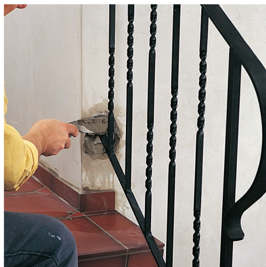
Typische Anwendung: Montage eines Treppengeländers.
