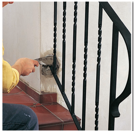
Typische Anwendung: Montage eines Treppengeländers.
