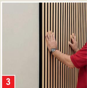
**3** Paneele ausrichten und fest andrücken. Bei größeren schwereren Paneelen ist eine zusätzliche mechanische Fixierung empfehlenswert.
