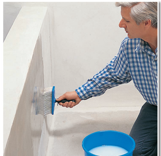
Grundieren eines saugfähigen Putzes vor Folgearbeiten, z. B. Anstreichen.
