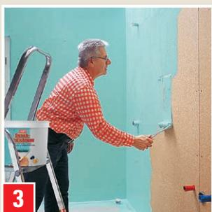
3 Appliquer deux couches de colle DUSCHABDICHTUNG en  $750 \text{ g/m}^2$  ( $= 0,5 \text{ l/m}^2$ ) au ROLLE FÜR DUSCHABDICHTUNG, généreusement et sans diluer. Appliquer du ruban DICHTUNGSBAND et la garniture DICHTUNGSMANSCHETTE en les faisant bien déborder.
