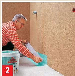
2 Noyer du ruban DICHTUNGSBAND dans la première couche encore fraîche de DUSCHABDICHTUNG dans le cas des joints d'angle.
