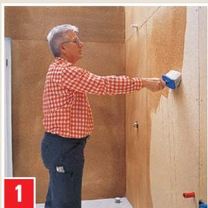
1 Sur les supports absorbants, p.ex. les panneaux de particules, appliquer une couche d'apprêt BESTE BASIS.
