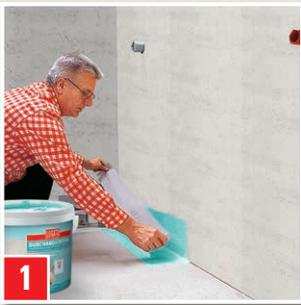
In den Eckfugen **DICHTUNGSBAND** in die frische erste Schicht **DUSCHABDICHTUNG** einbetten.
