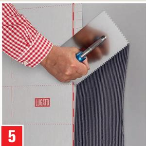
5 Für die Folgebahn wird 5 cm überlappend geklebt. Hierzu im Überlappungsbereich mindestens 6 cm DICHTKLEBER TURBO auftragen, Bahn vollflächig blasenfrei andrücken und wie in Punkt 3 glattstreichen.
