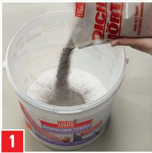
1 Anmischen: FLEX-ZUSATZ in Verpackungseimer geben. Mit max. 50 ml Wasser die Restmenge aus dem Kanister herauslösen und ebenfalls in den Eimer geben. DICHTMÖRTEL mit elektrischem Rührwerk klumpenfrei einrühren.
