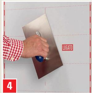
4 ABDICHTUNGSBAHN falten und blasenfrei einbetten und glattstreichen, z. B. mit Glättkelle oder Gummwalze.
