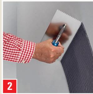
2 Klebstoff mit Zahnkelle (Blockzahnung 3 mm oder 4 mm) bahnenweise auf Untergrund auftragen.
