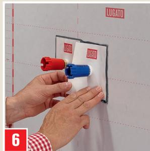
6 Systemeinbauteile (hier DICHTUNGSMANSCHETTE) im aufgetragenen Kleber einbetten und glattstreichen.
