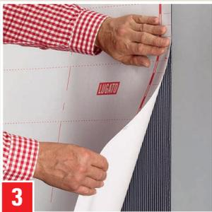
3 Die ABDICHTUNGSBAHN in den frischen Klebstoff einlegen und ausrichten.
