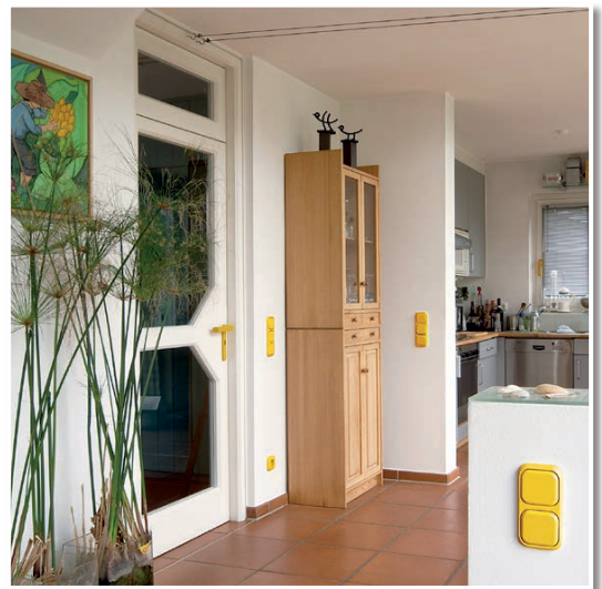
Neue Steckdosen. Mit ELEKTRIKERGIPS montiert.
