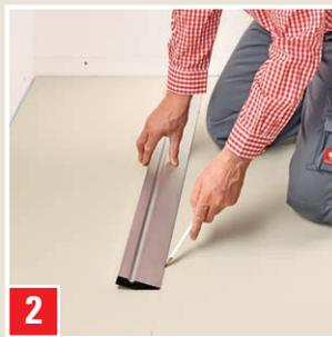
2 Restreindre la zone de travail à env. 2 à 3 largeurs de revêtement. Tracer une marque pour permettre de travailler proprement.
