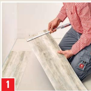
1 Déranger le revêtement design sec avant la pose et si nécessaire, le découper aux dimensions.
