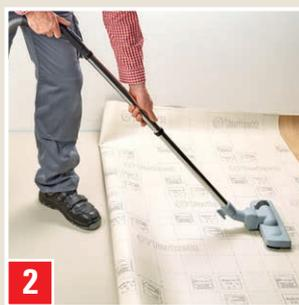
2 Replier avec précaution la moitié du revêtement dans le sens de la largeur et aspirer soigneusement le support et l'envers du revêtement. Le revêtement ne doit pas glisser quand il est replié. Si nécessaire, le lester.
