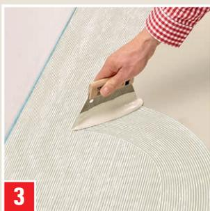
3 Bien mélanger avant utilisation. Répartir DESIGN- & PVC-BELAGS-KLEBSTOFF uniformément sur le support à l'aide d'une spatule à denture adaptée. Éviter la formation d'amas de colle.
