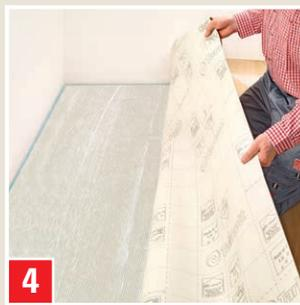
Une fois le temps d'aération écoulé, poser le revêtement replié et maroufler à l'aide d'un outil adapté. Répéter cette opération avec l'autre moitié de moquette.
