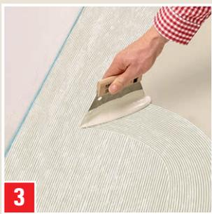
Bien mélanger avant utilisation. Répartir DESIGN- & PVC-BELAGS-KLEBSTOFF uniformément sur le support à l'aide d'une spatule à denture adaptée. Éviter la formation d'amas de colle.
