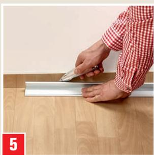
Pour finir, découper le bord aux dimensions précises à l'aide d'un cutter.
