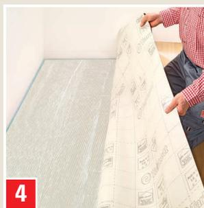
Den zurückgeschlagenen Belag nach der Ablüftezeit einlegen und mit einem passenden Werkzeug gut anreiben. Diesen Vorgang nun auch mit der anderen Hälfte wiederholen.
