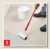
Mit einer Rolle gleichmäßig auf den Untergrund auftragen, Pfützenbildung vermeiden und 1-4 Stunden trocknen lassen.
