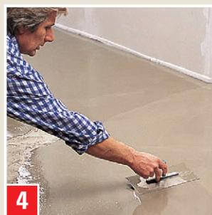
4 Favoriser le mélange de la masse à l'aide d'un plateau lisse. Utiliser le cas échéant un cylindre à points ou un râteau de jardinage. Travailler la masse dans un intervalle de 20 minutes environ. Protéger la masse fraîche des courants d'air et du soleil.
