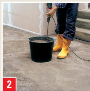
2 Mélanger le contenu du sac (20 kg) lentement dans 4,0 l d'eau propre, en mélangeant constamment au malaxeur. Au bout de 5 min, bien mélanger à nouveau. Ne pas mélanger plus de 2 sacs à la fois.
