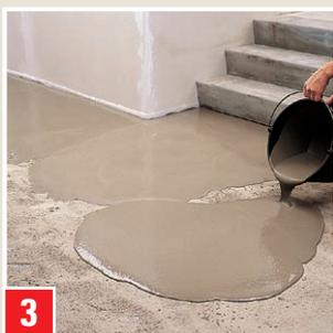
3 Verser le matériau par portions. Commencer au niveau d'un mur. Entre-temps, mélanger le sac suivant pour pouvoir verser rapidement un seau après l'autre.
