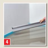
Durch Eintauchen eines Alu-Richtscheits und Messen des anhaftenden Mörtelfilms wird die hier erforderliche Systemüberdeckung von 5 mm gemessen. Werkzeug sofort mit Wasser reinigen.
