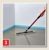
Die ausgebrachte Masse mit einem Rakel oder Gummischieber gleichmäßig verteilen. Frisches Material vor Zugluft und Sonne schützen.
