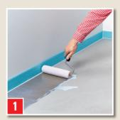
BESTE BASIS auf den Untergrund z.B. mit einer Rolle auftragen und je nach Saugfähigkeit des Untergrundes 1 bis 4 Stunden trocknen lassen.
