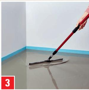
Die ausgebrachte Masse mit einem Raketel oder Gummischieber gleichmäßig verteilen. Frisches Material vor Zugluft und Sonne schützen.
