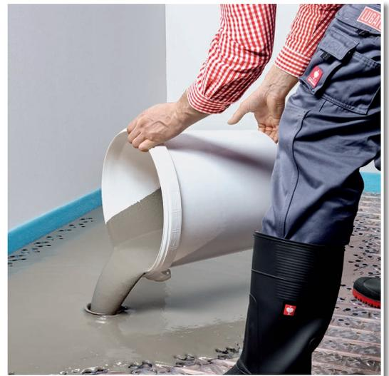
Verläuft von selbst und schafft ebene Oberflächen auf z. B. dünn-schichtigen Bodenerwärmungssystemen.
