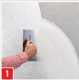
**Glätten eines rauen Wandputzes: FEINER FLÄCHENSPACHTEL** mit rostfreiem Stahlglätter dünn-schichtig aufkratzen. Anschließend frisch in frisch in gewünschter Schichtdicke auftragen und flächig abziehen. Vereinzelte Kellenschläge nach dem Trocknen abschleifen.
