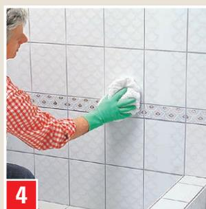
**4** Polir le carrelage à l'aide d'un chiffon humide dès que le mortier a durci.
