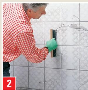
**2** Remblayer à fleur les joints au FUGENGRAU à l'aide d'une raclette en caoutchouc ou d'un platir à éponge. Racler le surplus.
