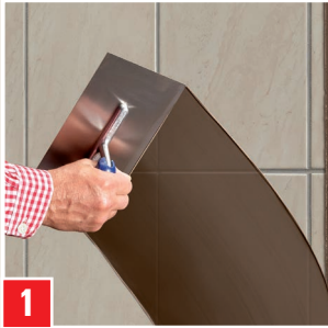
Auftrag von FLÄCHENSPACHTEL TURBO auf alten Fliesen zum Egalisieren des Fugenbildes.
