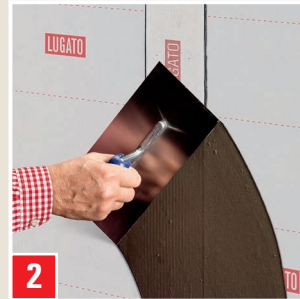
Auftrag von FLÄCHENSPACHTEL TURBO auf alten Fliesen zum Egalisieren des Fugenbildes.
