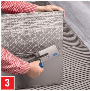
Coller le carrelage extérieur, immergé, pour surfaces fortement sollicitées et les dalles de 50 cm de côté et plus en intérieur en limitant au maximum les creux. Pour ce faire, appliquer également une couche de colle de 2 mm d'épaisseur environ à l'arrière des carreaux.
