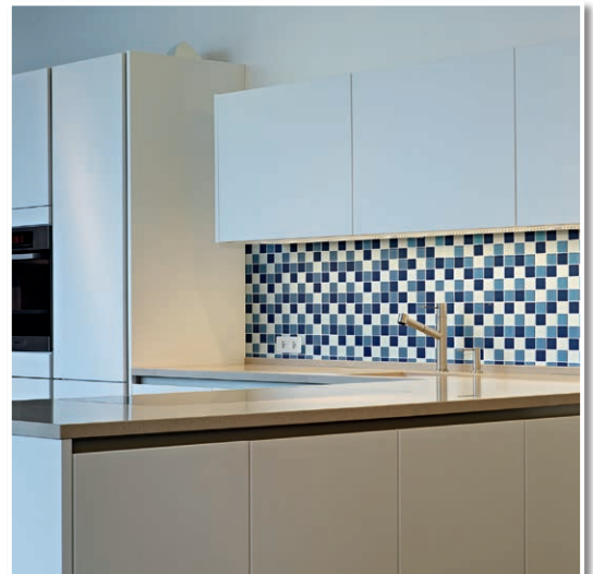
Glasmosaik als Fliesenschild in der Küche. Geklebt mit GLASMOSAİK-KLEBER.
