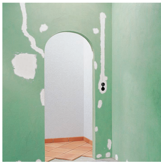
Rissverschluss mit GLATTE SACHE.
