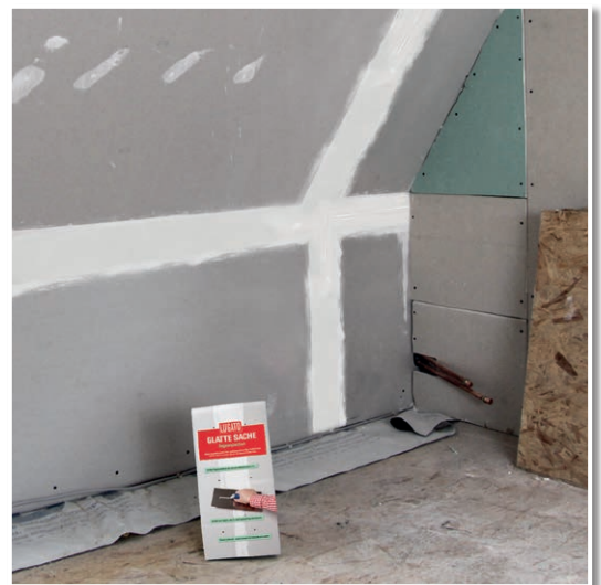
Dachausbau mit Gipskartonplatten: Fugen mit GLATTE SACHE FUGENSPACHTEL gefüllt.
