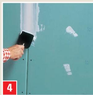
**4** Réaliser les joints de plaques de placoplâtre : appliquer la matière avec une spatule large et lisser. Les plaques peuvent être peintes ou tapissées au bout de 3 heures.
