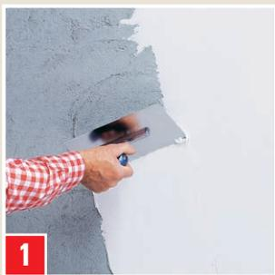
**1** Lissage des murs crépis : appliquer l'enduit de surface MALERSPACHTEL au lissoir.
