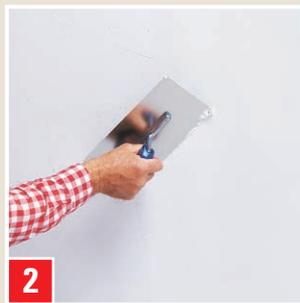
**2** Lisser au bout de 15 à 45 minutes. Pour ce faire, humidifier légèrement la couche d'enduit à l'aide d'une éponge ou d'un flacon pulvérisateur.
