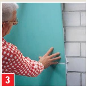
**3** Pose de plaques de placoplâtre : appliquer des galettes d'enduit espacées de 40 cm sur la face arrière, appuyer sur la plaque et aligner au niveau à bulle. Réaliser les joints au bout de 3 heures.
