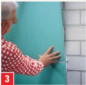
**Ansetzen von Gipskartonplatten:** auf der Plattenrückseite alle 40 cm Materialbatzen auftragen, Platte andrücken und mit Wasserwaage ausrichten. Nach 3 Stunden verfugen.
