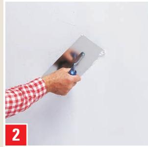
Nachglätten innerhalb von 15-45 Minuten. Dazu Spachtelschicht leicht anfeuchten mit Schwamm oder Sprühflasche.
