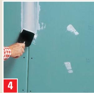
**Gipskartonplatten verfugen:** Material mit breitem Spachtel einbringen und nachglätten. Platten können nach 3 Stunden gestrichen oder tapeziert werden.
