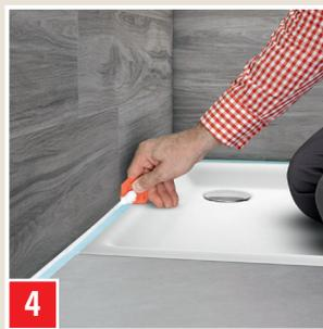
4 Dans les 15 minutes qui suivent, lisser avec FUGENGLÄTTER (humidifié avec SILICONGLÄTTMITTEL). Le niveau de matité maximum est atteint avec un lissage en une seule passe. Retirer immédiatement le ruban adhésif, lisser les bords des joints le cas échéant.
