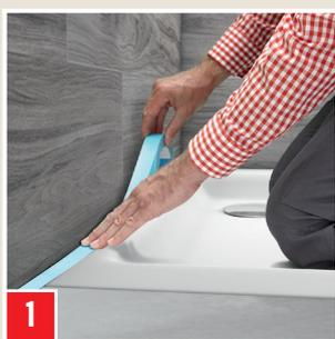
1 Avant l'étanchéification élastique, coller du ruban adhésif au niveau des bords des joints.
