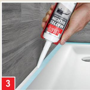
3 Appliquer MATTES SILICON dans le joint avec le pistolet applicateur.
