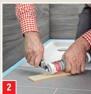
2 Couper la pointe de la buse en biais (en fonction de la largeur du joint) et la pointe de la cartouche.
