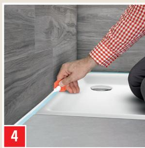
4 Entro 15 minuti spianare con FUGENGLÄTTER (inumidito con SILICONGLÄTTMITTEL). Il grado massimo di opacità si raggiunge con una sola stesura. Staccare subito il nastro adesivo, event. lisciare i bordi delle fughe.
