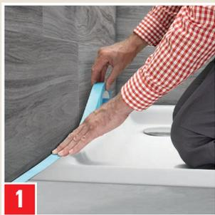
**1** Prima dell'impermeabilizzazione elastica, sigillare le fughe con nastro adesivo.
