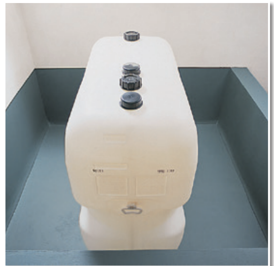
NEUER ANSTRICH – hier als Schutzanstrich für Ölauffangräume.
