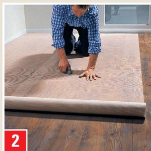
**NEU AUF ALT!** Agrafer l'armature **NEU AUF ALT!** en espaçant les agrafes d'env. 25 cm. Prévoir un chevauchement de 5 cm pour les bandes.
