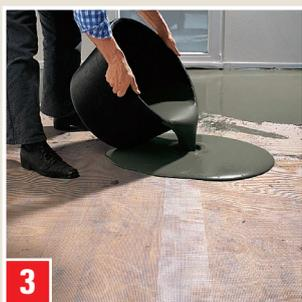
**NEU AUF ALT!** Verser en plusieurs fois, en commençant au niveau d'un mur, épaisseur minimale de 5 mm sur les sols en bois.
