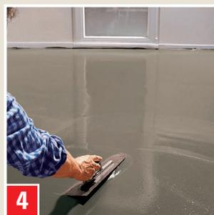
Aider les masses à se rejoindre à l'aide d'une truelle lisse, utiliser le cas échéant un tambour à picots ou un râteau. Protéger la matière fraîche des courants d'air et du soleil.
