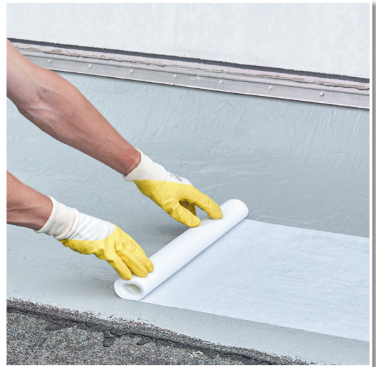
ABDICHTUNGS-VLIES zur norm-konformen Abdichtung mit PROTEKT Flüssigkunststoffen.
