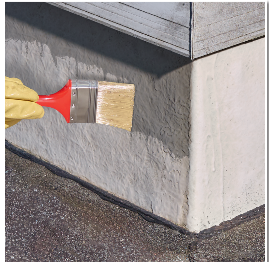
HAFTGRUNDIERUNG KUNSTSTOFF mit Pinsel oder Fellrolle auf den Untergrund auftragen.
