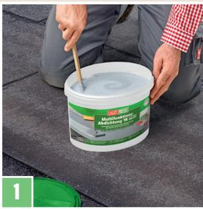
Masse mit langsam laufendem Rührwerk oder Rührstab gründlich bis in die Ecken des Eimers umrühren, Lufteintrag vermeiden.
