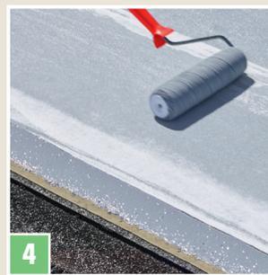
ABDICHTUNGS-VLIES mit trockener Rolle hohlraum- und blasenfrei abrollen und andrücken/einbetten. Auf vollständige, satte Durchtränkung achten. Die Durchtränkung ist erfolgt, wenn eine dunkle Umfärbung im ABDICHTUNGS-VLIES entsteht.
