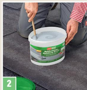
Die Masse homogen mit langsam laufendem Rührwerk oder Rührstab einrühren. Lufteintrag vermeiden.
