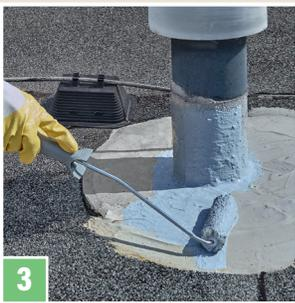
3 Mind. 1,5 kg werden pro m<sup>2</sup> auf den Untergrund als gleichmäßige Schicht mit Rolle...
