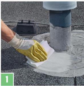
1 Untergrund von Staub und trennenden Schichten reinigen. Ggf. unter Einsatz von MULTIFUNKTIONS-REINIGER.
