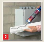
Klebstoff mit Auspresspistole auf Rückseite des Kabelschachtes auftragen.
