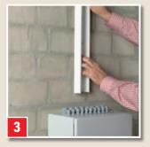
Innerhalb 5 Minuten Bauteile zusammenfügen, andrücken und ausrichten. Schwere Bauteile bis zur Erhärtung verpressen oder abstützen.
