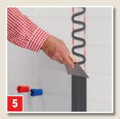
Zum Kleben von Systemeinbauteile auf ABDICHTUNGSBAHN (Abb. 5-7): BOMBENFEST ausspritzen und mittels Zahnspachtel mittig über dem Stoßbereich 12 cm breit auftragen.
