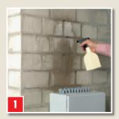
Kleben eines Kabelschachtes auf ein Kalksandsteinmauerwerk: saugfähige Untergründe anfeuchten.
