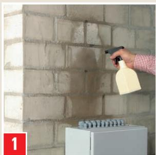
**1** Pour coller une goulotte de câbles sur une maçonnerie en briques silico-calcaires : humidifier les supports absorbants.
