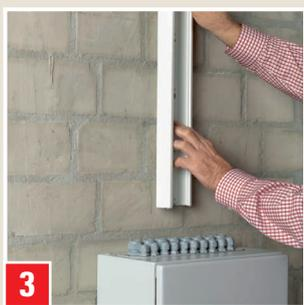
**3** Innerhalb 5 Minuten Bauteile zusammenfügen, andrücken und ausrichten. Schwere Bauteile bis zur Erhärtung verpressen oder abstützen.
