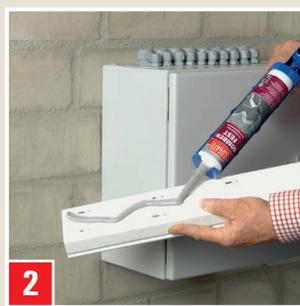
**2** Klebstoff mit Auspresspistole auf Rückseite des Kabelschachtes auftragen.
