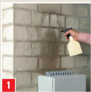
**1** Kleben eines Kabelschachtes auf ein Kalksandsteinmauerwerk: saugfähige Untergründe anfeuchten.
