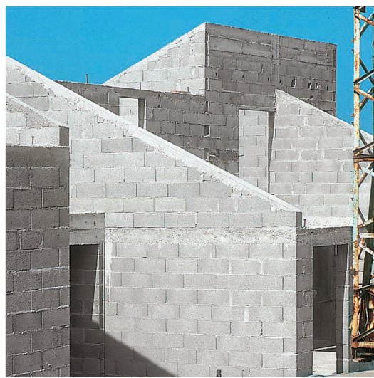
Wohnsiedlung. Vorbereiten von Planblockmauerwerk für Dekorputze mit ROHBAUSPACHTEL AUSSEN.
