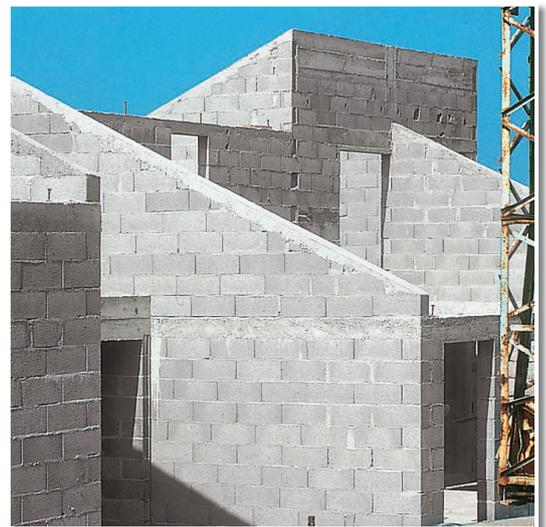
Habitations. Préparation de l'ouvrage en briques cellulaires pour la pose d'enduits décoratifs avec l'enduit de surface ROHBAUSPACHTEL AUSSEN.
