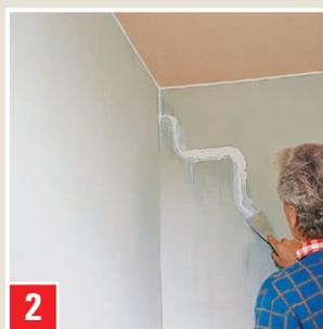
Lisser avec une spatule humidifiée. Le cas échéant, répéter l'opération après séchage à cœur. Laisser sécher à cœur RISS- UND FUGEN-ZU avant d'effectuer les travaux suivants.
