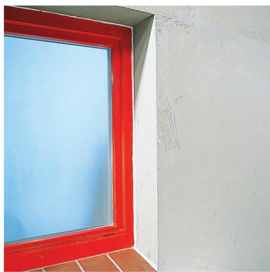
Colmatage des joints de raccordement entre une fenêtre et l'ouvrage de maçonnerie.
