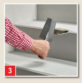
Treppenstufe reparieren: Schadstelle mit R & R frisch in frisch reparieren.
