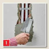
Mauerschlitze schließen: den zu verschließenden Schlitz mit R & R füllen. Hervorgetretenen Mörtel mit der Kelle oberflächenbündig abstreifen.
