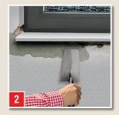
Putzausbruch reparieren: R&R mit Kelle oder Glätter aufziehen. Nach 20-40 Minuten mit Schwamm- oder Filzbrett und wenig Wasser nacharbeiten.
