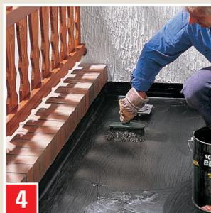
**4** Abdichten eines Balkons: SCHUTZFOLIE aufstreichen vor dem Einbringen eines Estrichs. In den Eckfugen LUGATO DICHTUNGSBAND nicht vergessen.
