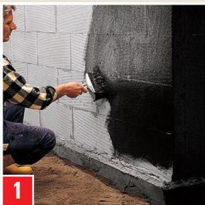
**1** Abdichten einer Porenbeton-Kellerwand: SCHWARZER BLOCKER SCHUTZFOLIE unverdünnt mit Quast auftragen.
