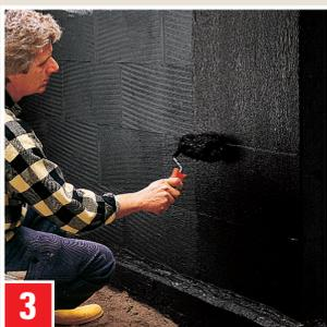
**3** Nach Trocknung zweiten Auftrag aufrollen. 2 Tage trocknen lassen.
