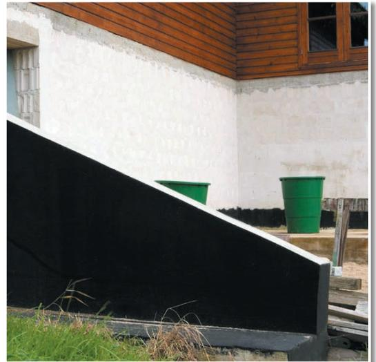
SCHWARZER BLOCKER SCHUTZLACK gegen Bodenfeuchtigkeit an einer Mauer vor Erdreichanschüttung.
