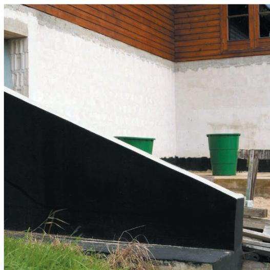
Aspect après application d'une couche de SCHWARZER BLOCKER SCHUTZLACK sur un mur pour le protéger de l'humidité du remblai en terre.
