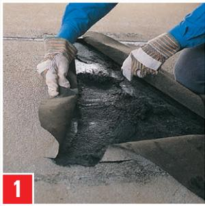
**Reparatur einer Bitumenbahn:** Beulen in der Dachbahn aufschneiden. Bahnen zurückschlagen. **SCHWARZER BLOCKER SPACHELMASSE** auf trockenen Untergrund auftragen.
