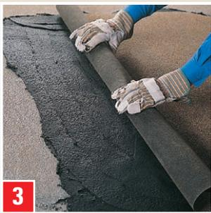
Zum Abdecken der Reparaturstelle neue Bitumenbahn in die frische Spachtelschicht legen und andrücken.
