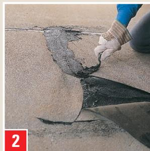
Presser les bandes sur le support et appliquer une couche au niveau des joints. Ensuite, enduire généreusement.
