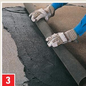
Pour masquer la réparation, placer une nouvelle bande de bitume sur la couche de mastic fraîche et presser.
