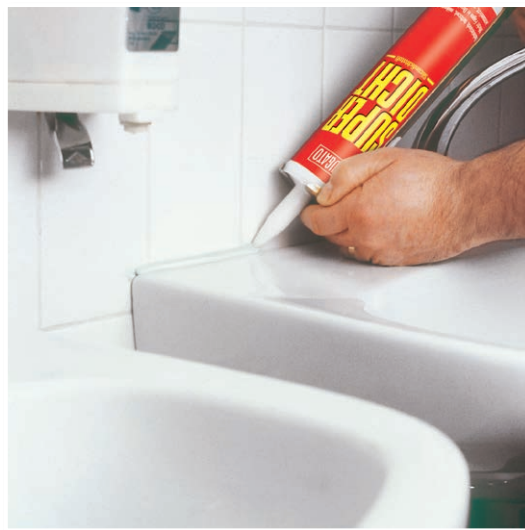
Réaliser des joints à élasticité durable sur les lavabos.
