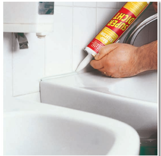
Fuge am Waschbecken dauerelastisch abdichten.
