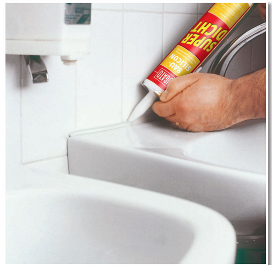
Fuge am Waschbecken dauerelastisch abdichten.
